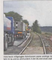
Viele heute stillgelegten Bahnstrecken sind wichtige Verbindungen in grenzüberschreitenden Personen- und Güterverkehr. Foto: G. Hofsch
